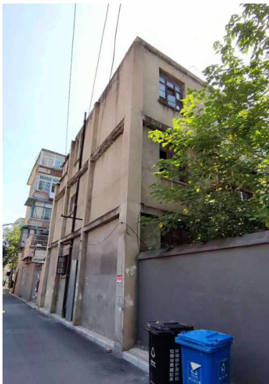
增设圈梁、构造柱
