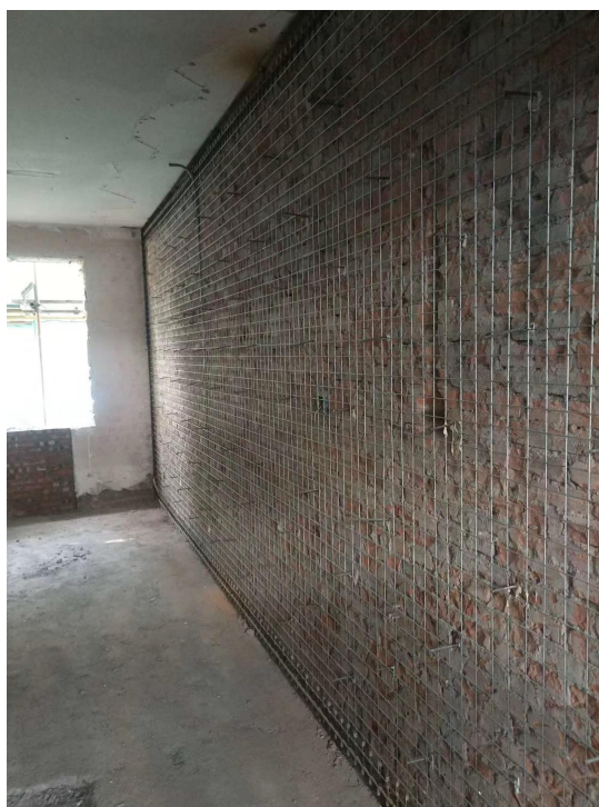
外加钢筋网-砂浆面层
