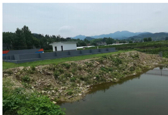
槐树湾乡新建 400t/d 污水处理站
