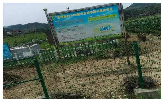
槐树湾村现有 200t/d 污水处理站
