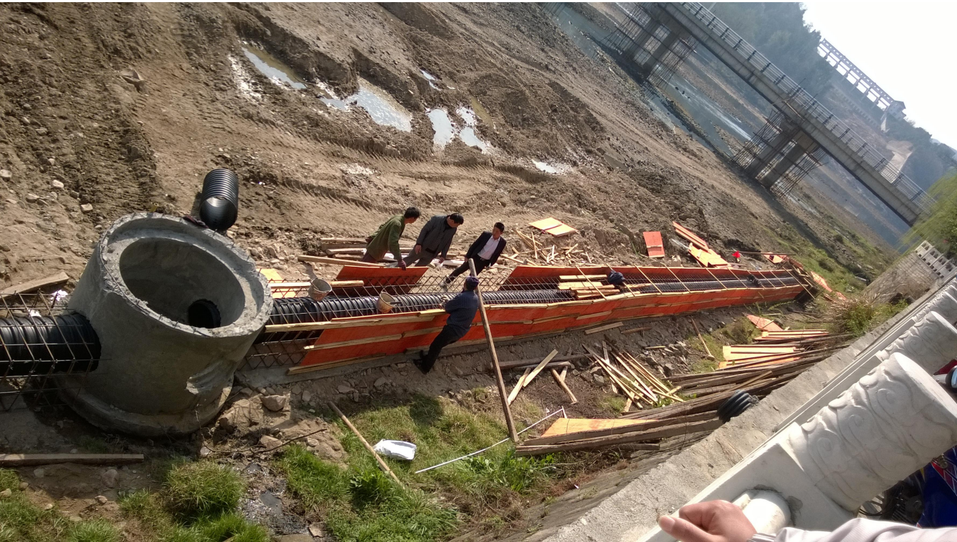
史河西岸现状污水管施工现场
