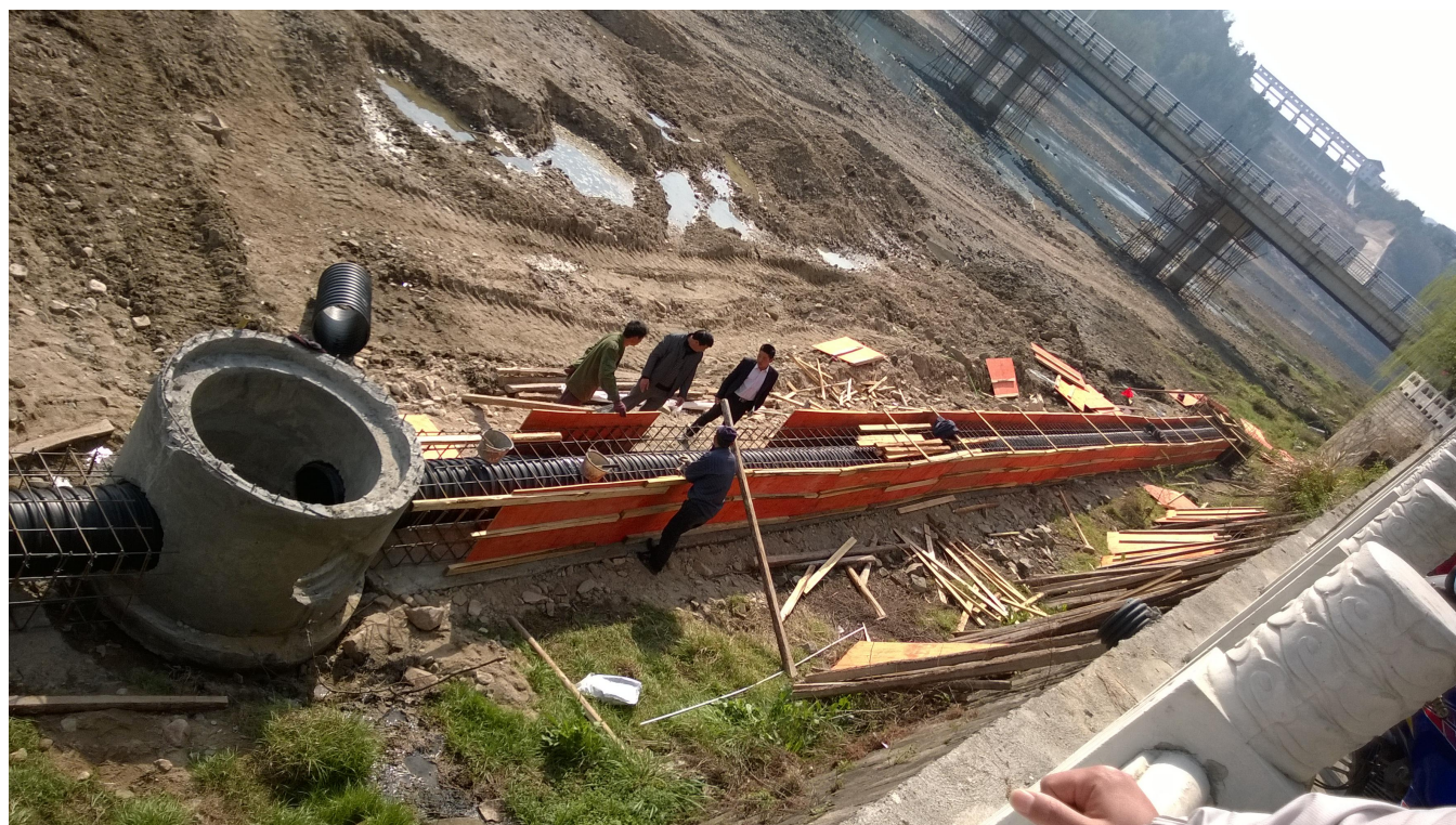
史河西岸现状污水管施工现场
